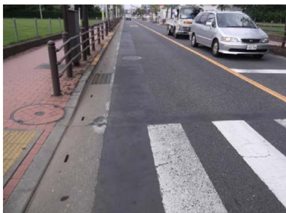
亀甲クラック補修 延命施工(長寿命化)
