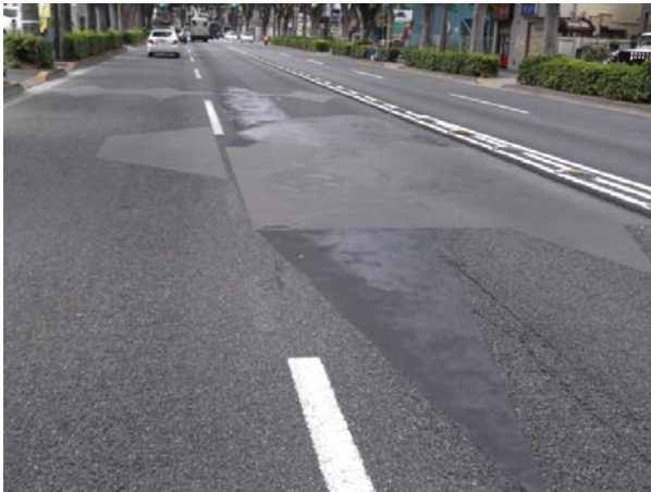
ポーラスアスファルト舗装の部分凹部の充填補修
