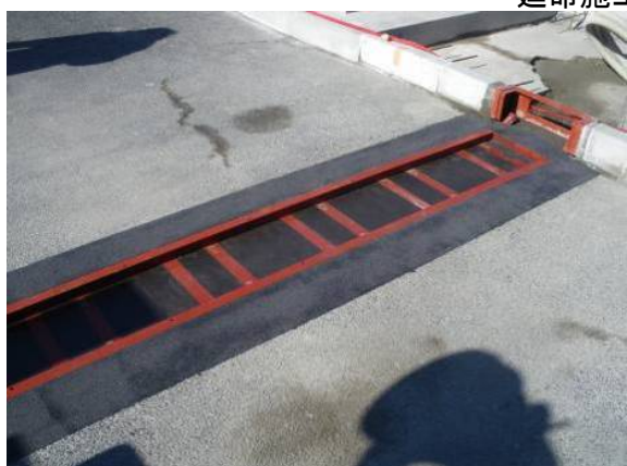
高速道路の料金所 各種センサー類の埋設・固定
