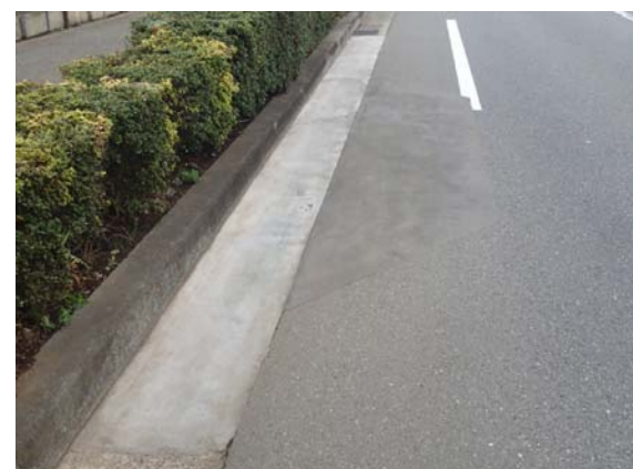
エプロン部、水溜り補修
