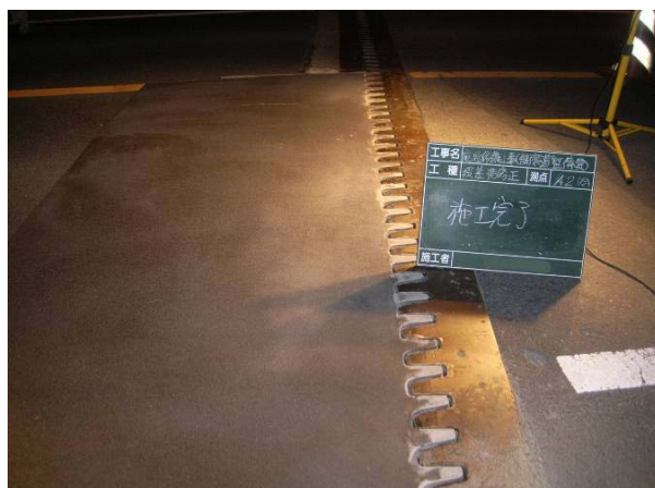
鋼製伸縮装置を含む段差修正完了
