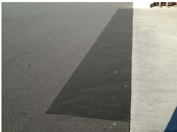
各種入口のアスコン側の沈下段差修正 フォークリフトのあおり解消
