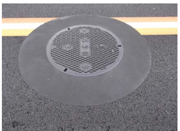
マンホール取換後の取り合い段差修正
