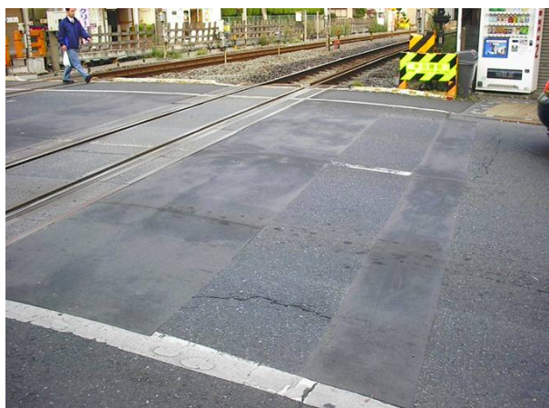
踏み切り前後の路面補強と 段差振動の抑制事例
