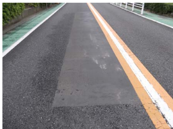
亀甲クラック補修 延命施工(長寿命化)
