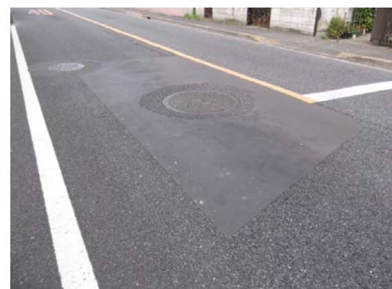
マンホール周囲の段差修正
