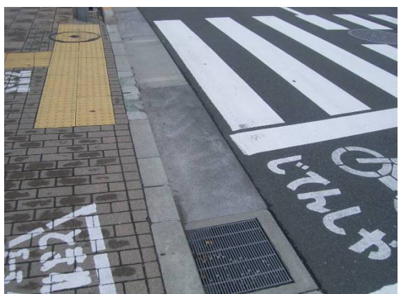
横断歩道エプロン部、水溜り補修
