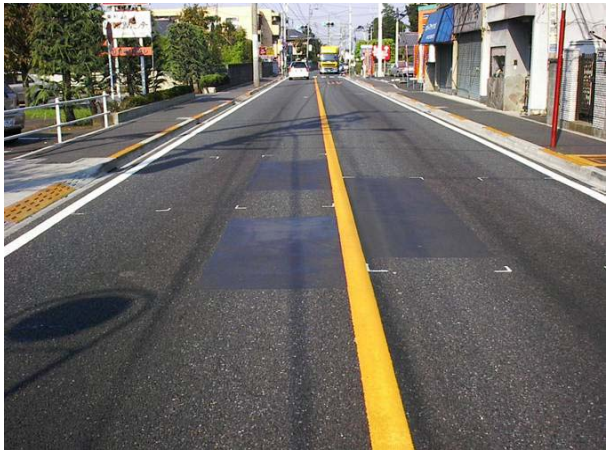
部分凹部の充填補修
