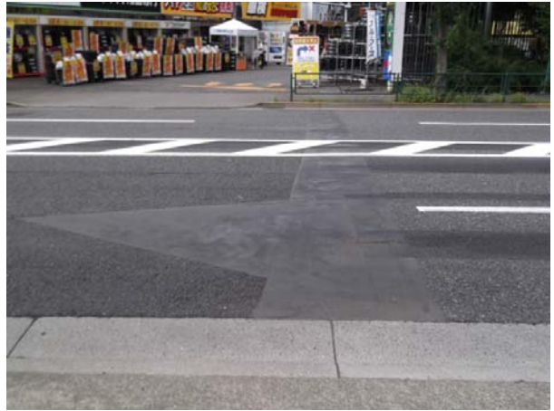
舗装ジョイントなどの段差修正
