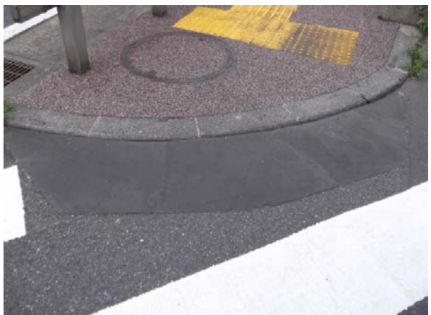
歩道切り下げ部の段差修正 バリアフリー化
