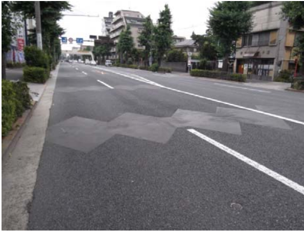
舗装ジョイントなどの段差修正
