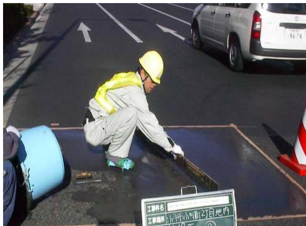
アスクリートキット施工状況
