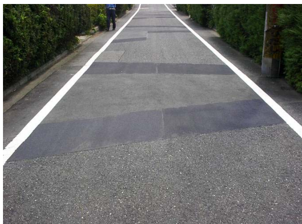
水道復旧箇所での経年段差の補修
