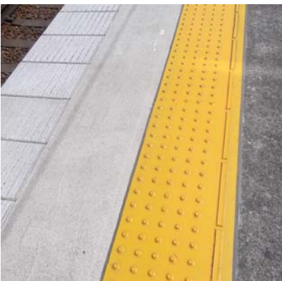
点字タイルの取替え施工
