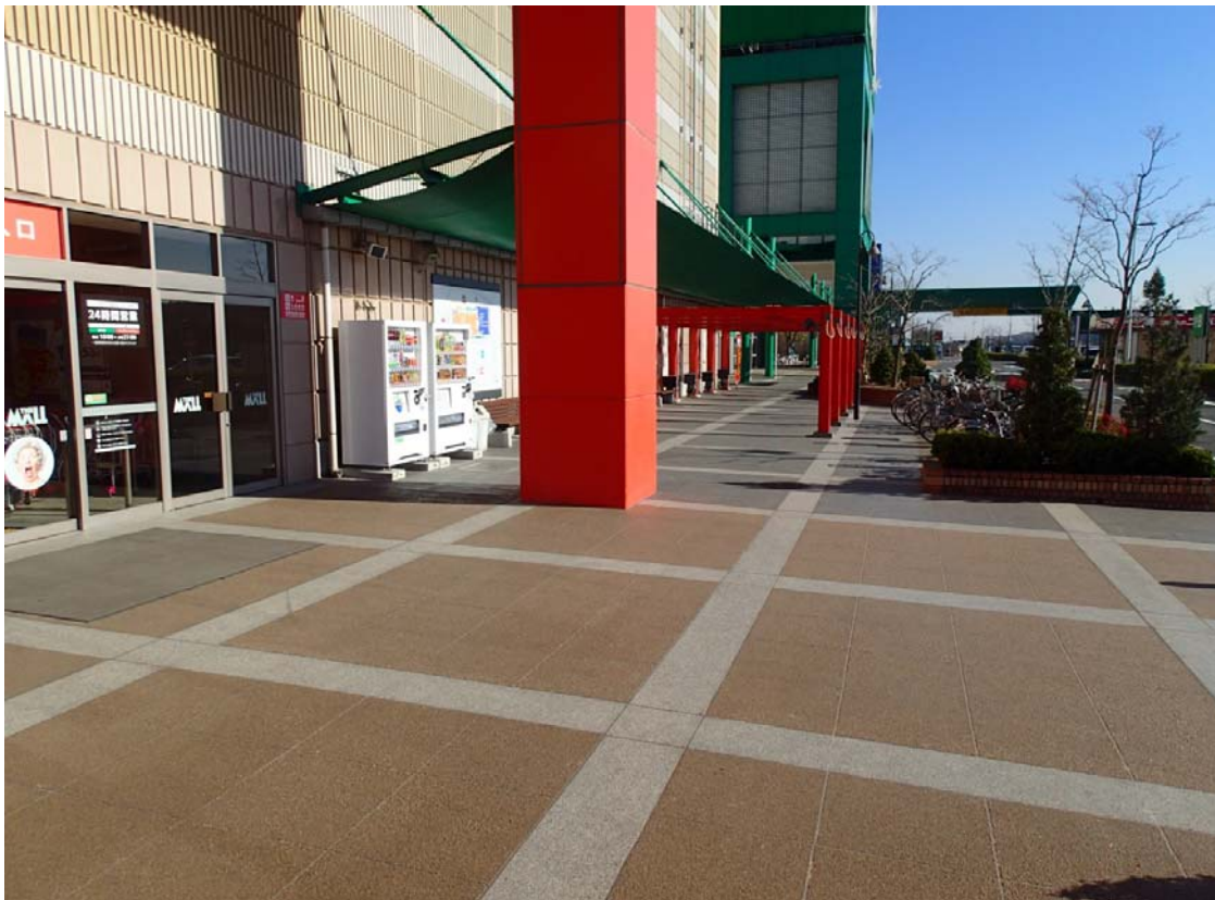
写真1. 西友入口付近
