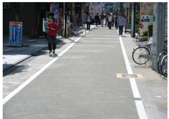
ニート工法（HC使用例）
