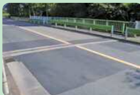
橋梁伸縮装置 前後の段差修正
