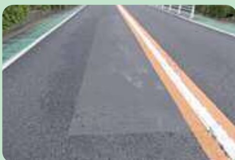
亀甲クラック 発生箇所への 補修・延命施工
