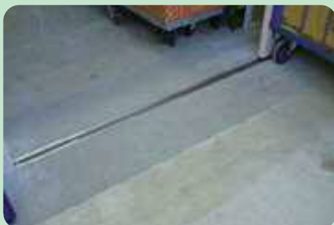
床の 段差修正
