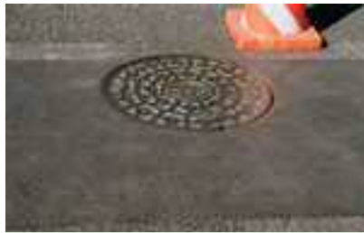
施工後の状態
