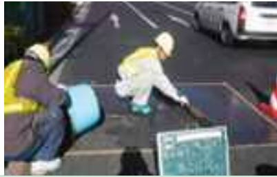
混合した材料を施工箇所に均した後、金コテ仕上げします。
