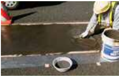
金コテ仕上げ後、撒砂を散布します。
