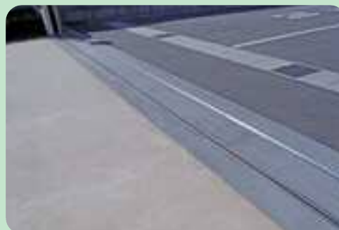
乗り入れ口 の段差修正
