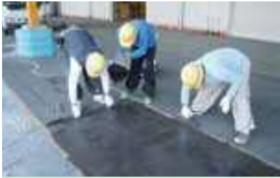
混合した材料を施工箇所に均した後、金コテ仕上げします。
