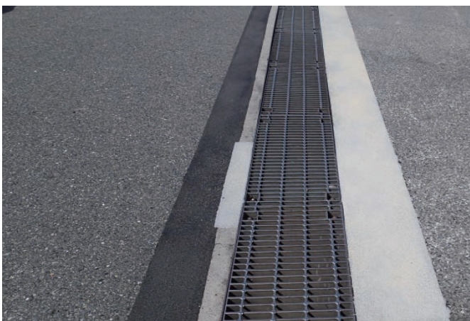
側溝際の段差修正
