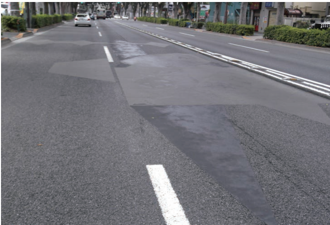
部分凹部の充填補修
