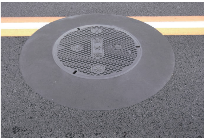
マンホール取換後の取り合い段差修正
