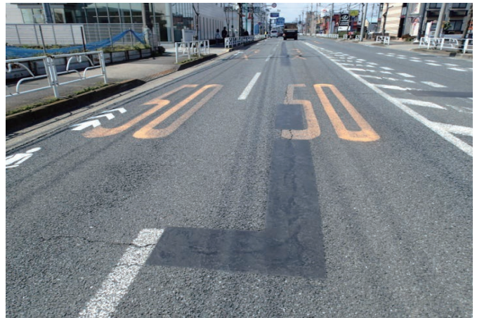
クラック発生箇所の補修
