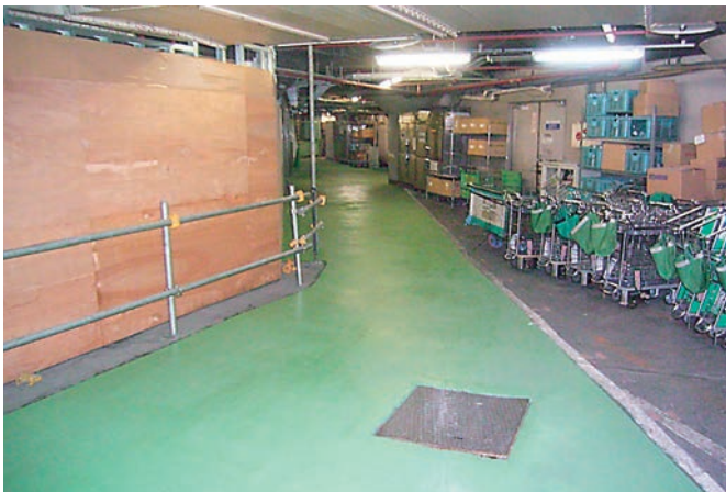
通路の改修(着色も可能)
