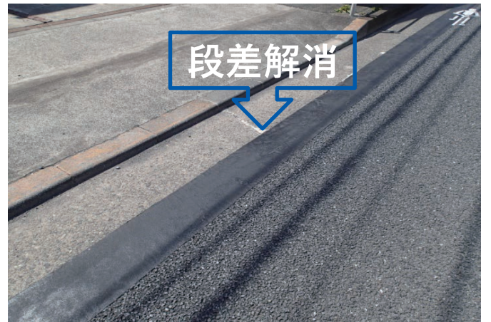
エプロンとの取り合い段差修正 20~30cm幅で容易に段差解消
