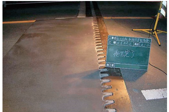
鋼製伸縮装置を含む段差修正
