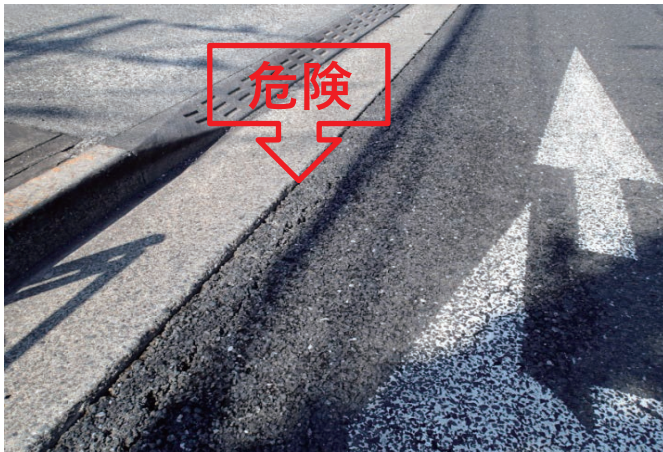
エプロン部との取り合い段差 エプロン部の段差は自転車の転倒を招く
