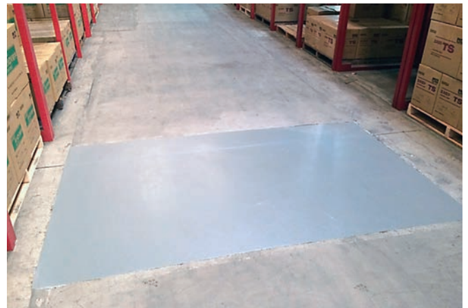
倉庫内構造部の破損段差修正 陥没補修にも適用可能
