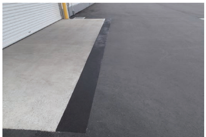
倉庫入口段差修正 リフトの煽り防止
