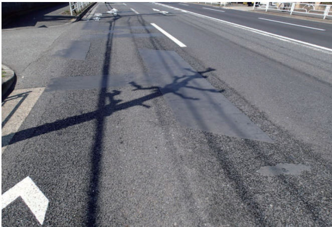
部分損傷部の補修
