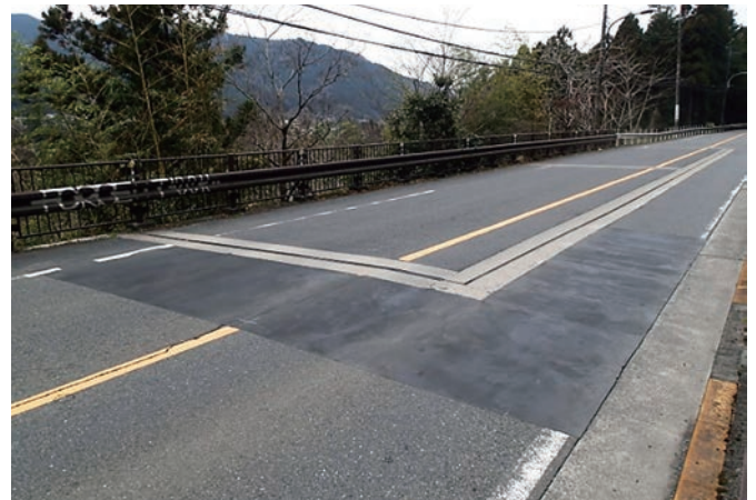
部分橋梁盛土側取り合いの段差修正
