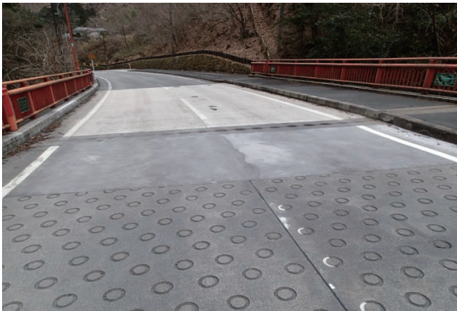
CO舗装の段差修正
