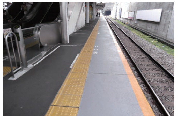
笠石ブロック部を嵩上げ+仕上げ
