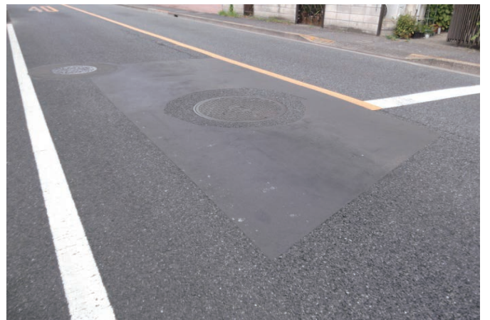
マンホール前後の段差修正
