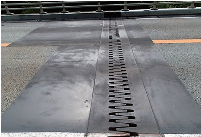
伸縮装置の高上げを伴う段差修正
