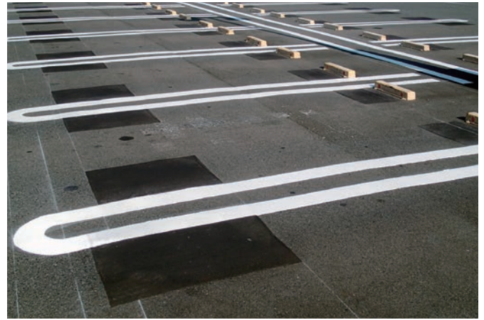
駐車場内轍掘れ修正
