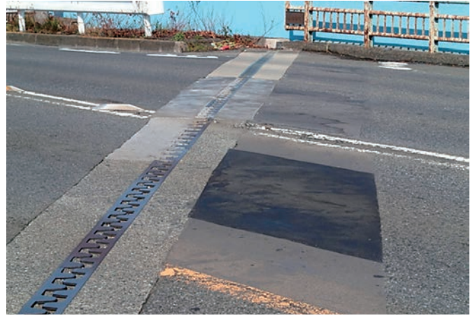
伸縮装置および取り合い段差修正
