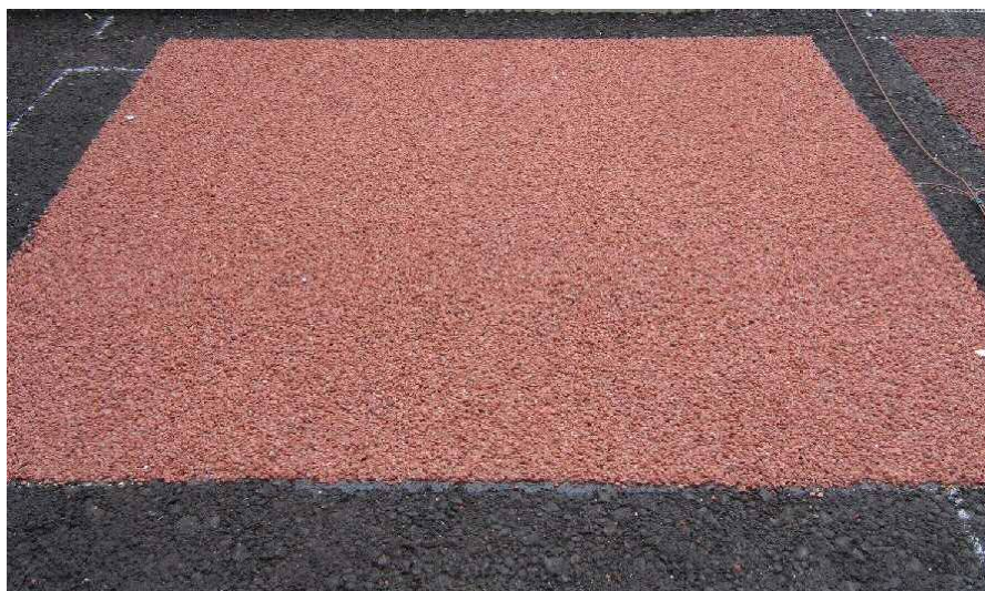
図2 セラグリップ・クールHC-Rの施工
