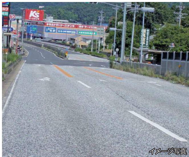
明色混合物工法(国道19号線)
