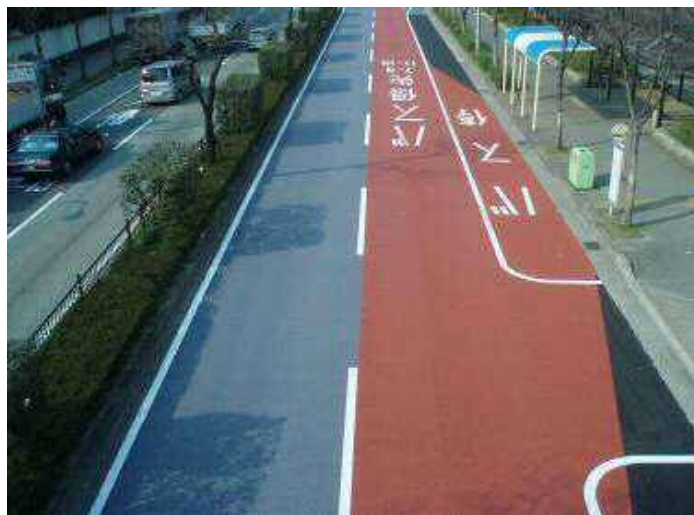
セラドレン施工例
