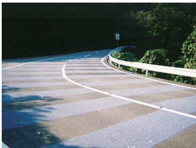
骨材：スーパーシノパール極光 A-1粒 キラキラ光る骨材で施工し、ドライバーの注意を喚起します。
