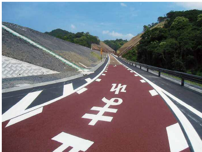
骨材：セラサンド HR A-1粒 高速道路の出口。視認性を高めています。
