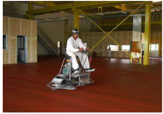
タココンチール (騎乗式仕様・耐摩耗塗床材)
