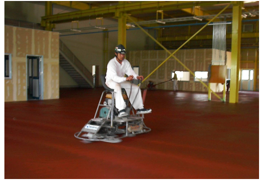
タフコンスチール（騎乗式仕様・耐摩耗塗床材）
